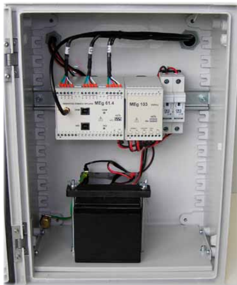
Obr. 3: Pohled do skříně montážní sestavy indikátoru MEg61.4 s kabelem prutové a YAGI antény
